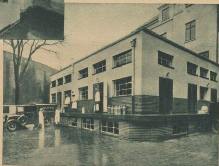
Neuzeitliche Bauten — neuzeitliche Brennstoffe Im Molkerei-Naubau Lehmman, Stiftstraße, dient ausschließlich Gas als Wärmequelle. Rückansicht des Molkereigebäudes
