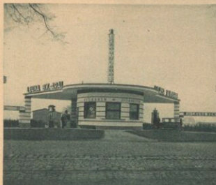
Großtankstelle „Liststadt“ Podbielskistraße 241
