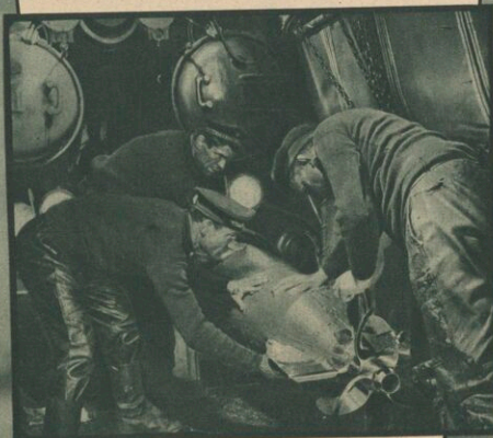
Im Maschinenraum des U-Boots
